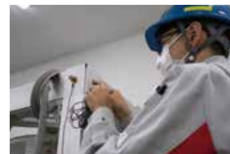
加速度計の取り付け
