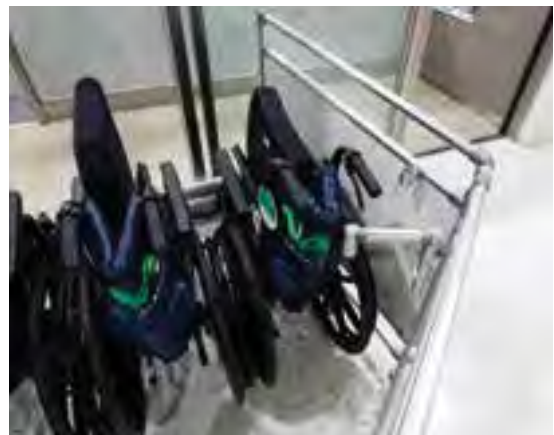
รั้วสำหรับพื้นที่เก้าอี้รถเข็นจะมีการติดบานพับเชื่อมไว้ที่หัวมุม และสามารถเปิด ออกเพื่อขยายพื้นที่
