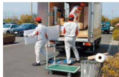
軽量のアルミ製のフレームや組立前の機器は重機がなくても積み下ろしが可能。
