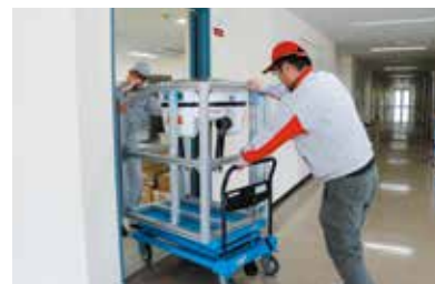
今回、一番狭かったのは、設置する部屋の扉の間口。組立前なら台車での搬入が可能。
