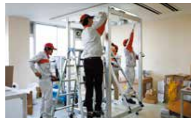
四隅に立てた柱に、脚立で持ち上げた天井部分をはめ込み、固定したら骨組みの完成。
