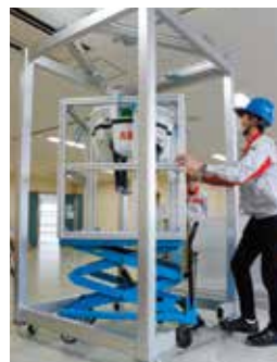
昇降機能付きの台車をフレームの中心に入れ、ロボットを持ち上げて固定する。
