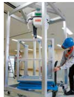
ロボットが載ったら、治具を取り外せば搭載作業が完了。
